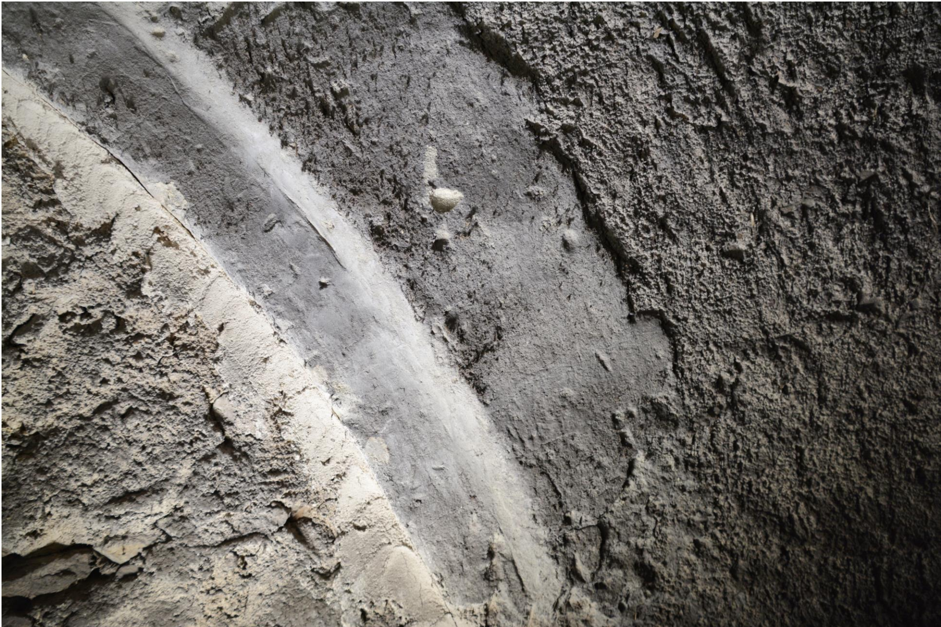
Polodetail rozdílu struktury hlazené jemné omítky okenní pasparty a hrubé omítky základních ploch.
