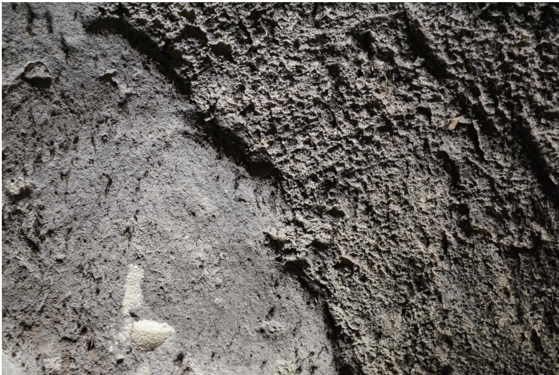
Detail rozdílu struktury hlazené jemné omítky okenní pasparty a hrubé omítky základních ploch.
