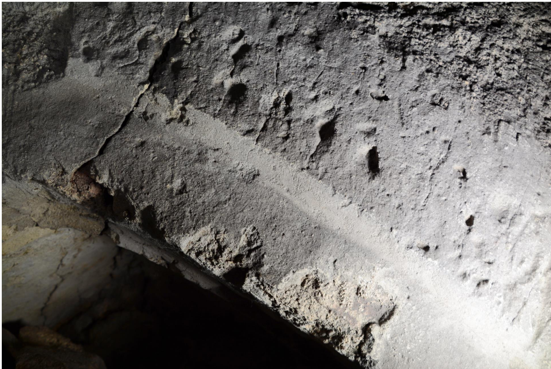
Dobře viditelný detail původního bílého vápenného nátěru vnitřního pásu a přechodového výžlabku okenní pasparty.
