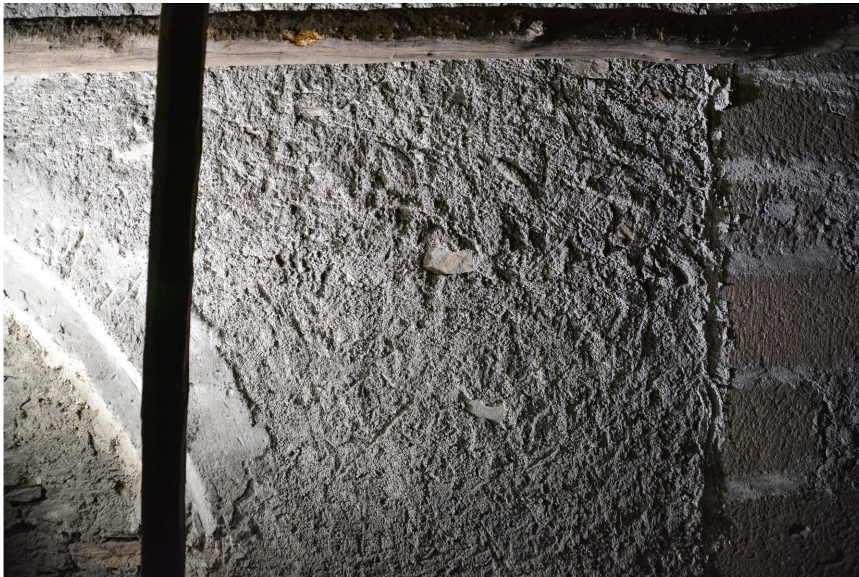
Celkový pohled zachované středověké exteriérové omítky na vnější straně severovýchodní stěny jižní lodi datované do rozmezí let 1300-1320.
