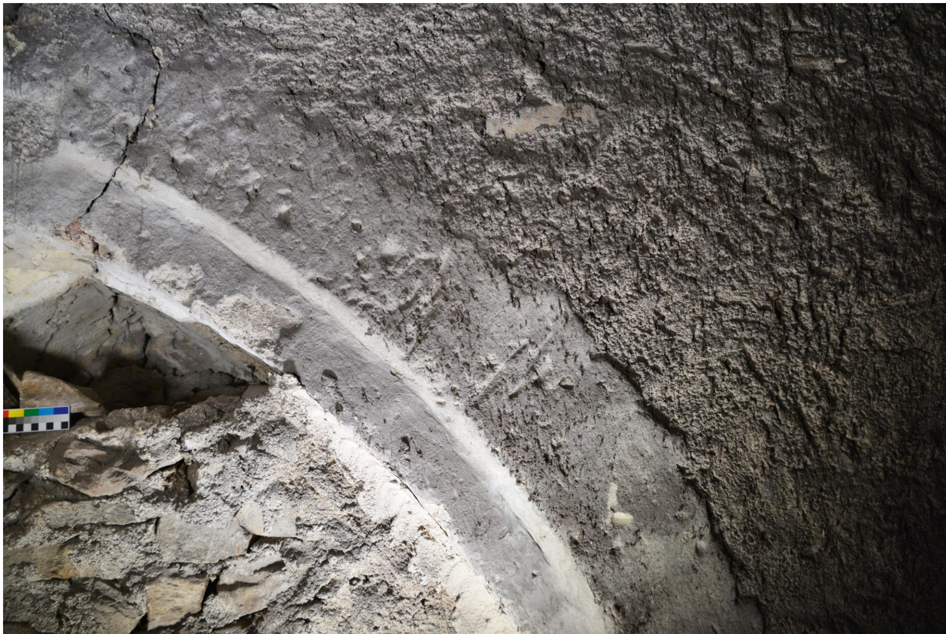
Polodetail hlazené pasparty lomeného okna a hrubé omítky základních ploch.
