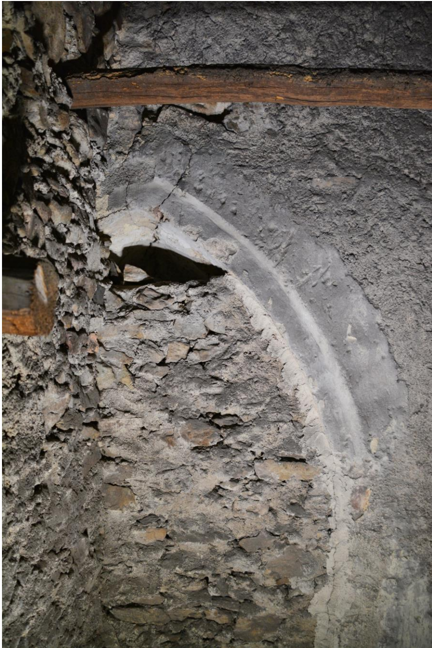
Celkový pohled na druhotně zazděné gotické lomené okno s původní odstupněnou jemnozrnnou hlazenou paspartou.
