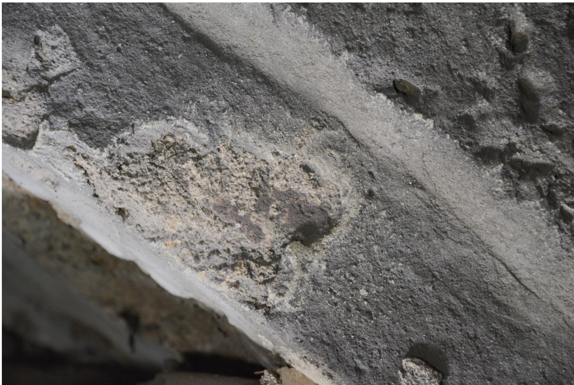
Detail odpadlé části jemné omítky okenní pasparty odhalující cihelnou tvarovku špalety okna se zbytky podkladové hrubé omítky základních ploch.
