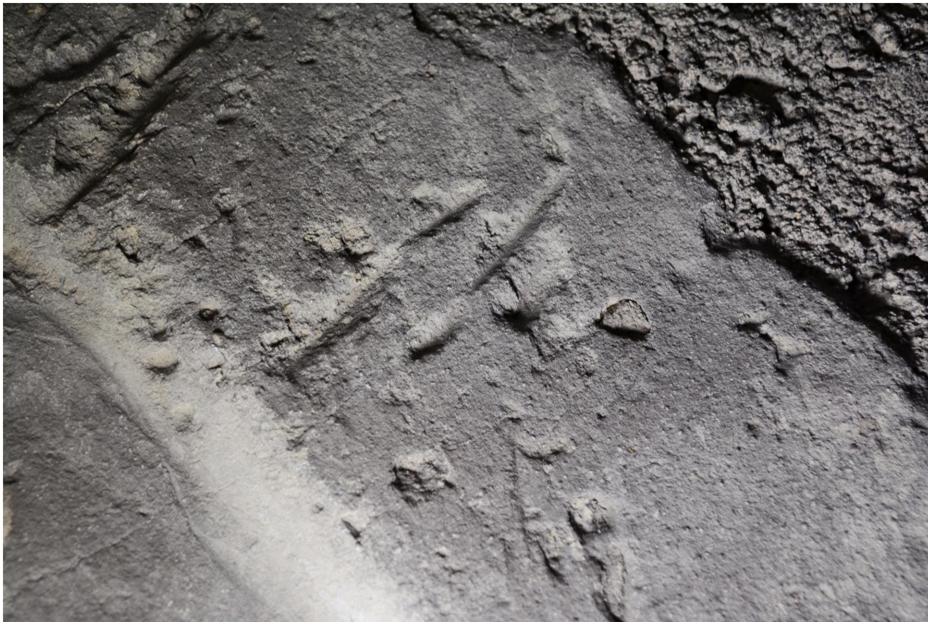
Detail stop nástrojů v hlazené jemné omítce okenní pasparty a prostupujících velkých zrn podkladové hrubé omítky základních ploch.
