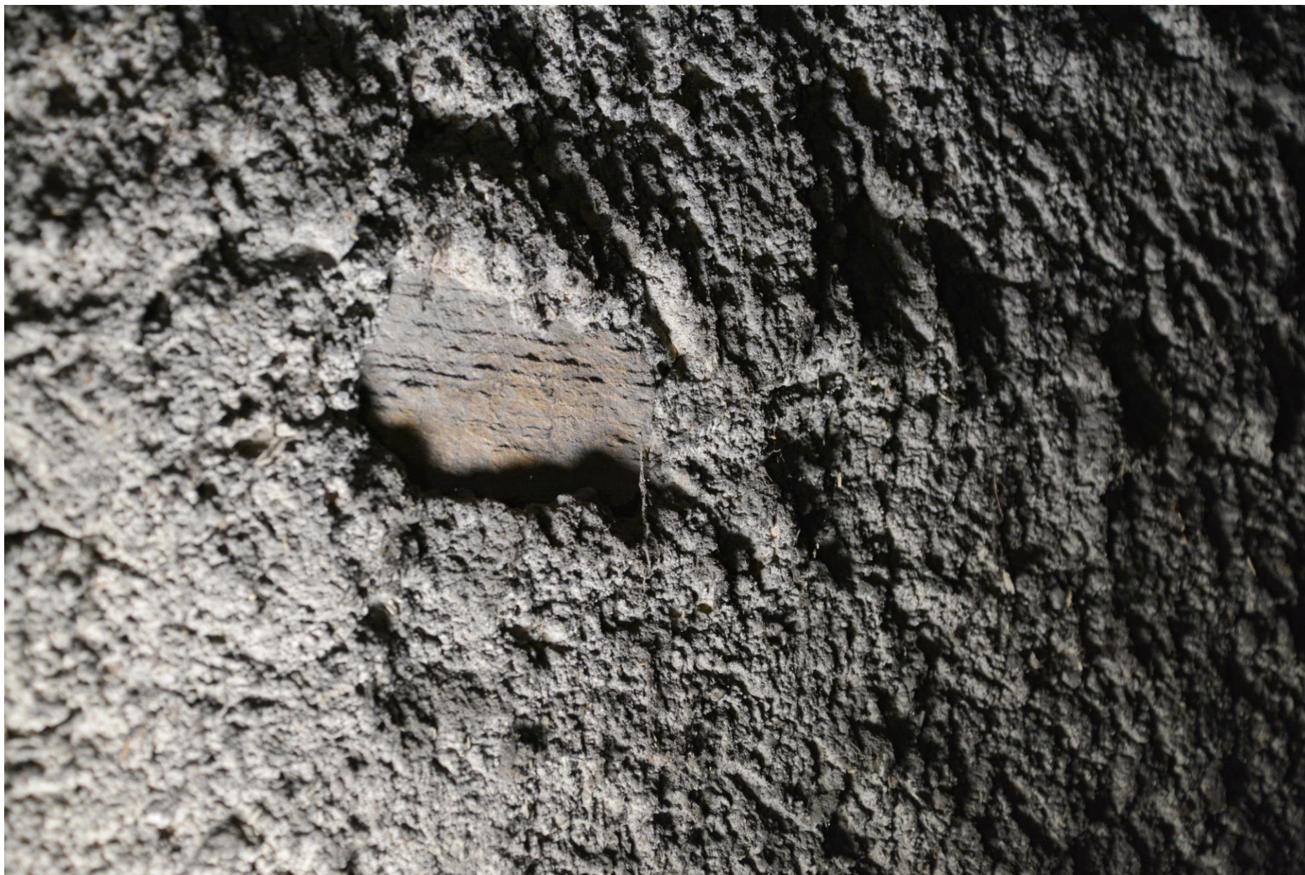
Detail hrubé omítky základních ploch.
